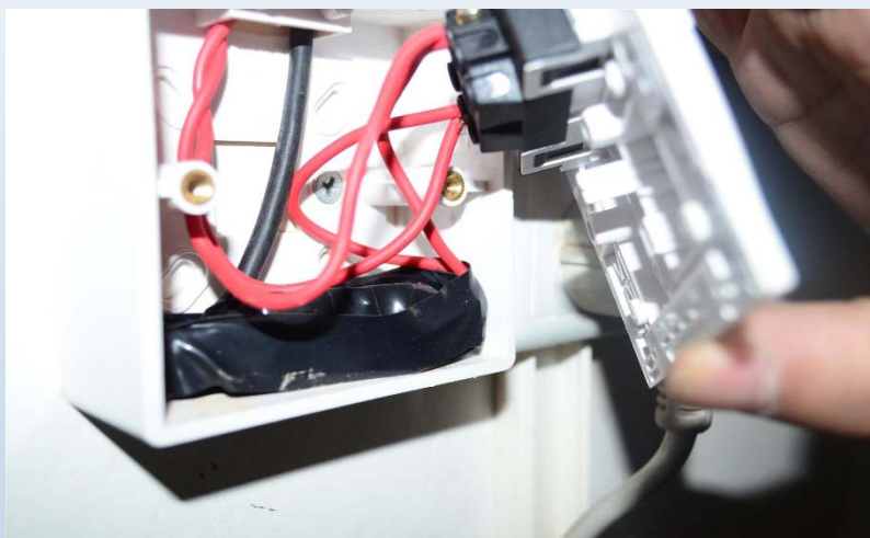
灯光联动控制模块安装在照明灯的开关里面
